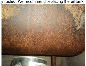
OIL TANK WET AND RUSTED ON BOTTOM
