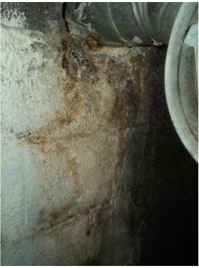
EFFLORESCENCE UNDER BOILER FLUE
