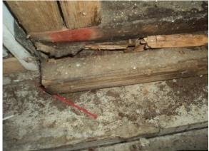
WOOD DETERIORATION SILL LEFT SIDE GARAGE
