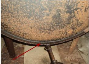
OIL TANK WET AND RUSTED ON SIDE
