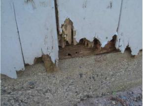
WOOD DETERIORATION SIDING AND SILL GARAGE
