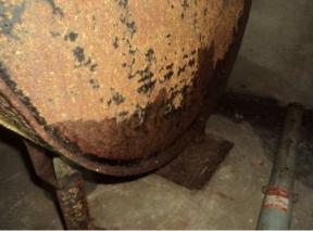
OIL TANK WET AND RUSTED ON SIDE
