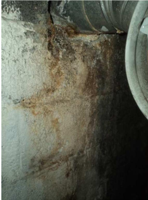
EFFLORESCENCE UNDER BOILER FLUE
