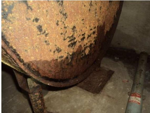
OIL TANK WET AND RUSTED ON SIDE
