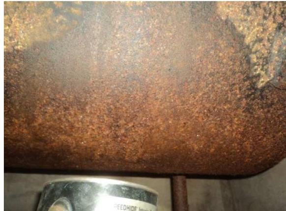
OIL TANK WET AND RUSTED ON BOTTOM
