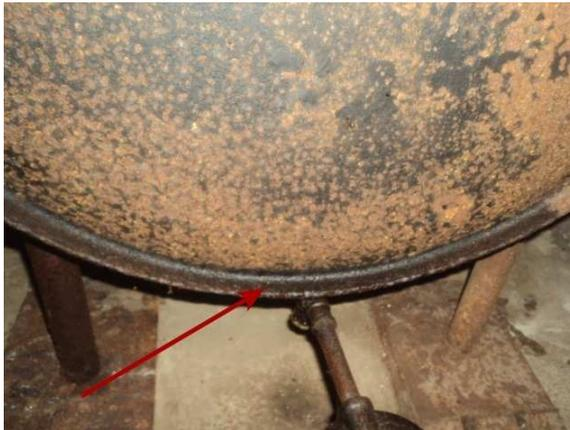
OIL TANK WET AND RUSTED ON SIDE
